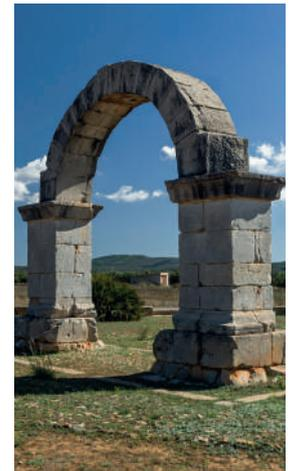
con della paglia, sulla cui superficie concava venivano allettati i conci della volta fino al completamento del sesto, e, in seguito, si rimuoveva la terra da sotto la volta. Il cuneo fondamentale che chiude l'arco e mette in atto le spinte di contrasto è quello centrale: la chiave d'arco, ovvero la chiave di volta.
