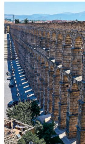
costruzioni ad arcate cominciava con la ricerca e l'individuazione delle sorgenti da utilizzare, che avrebbero dovuto garantire un regolare e abbondante flusso di acqua di buona qualità. Si passava poi allo studio del pendio del terreno, per calcolare la giusta inclinazione dell'acquedotto.
